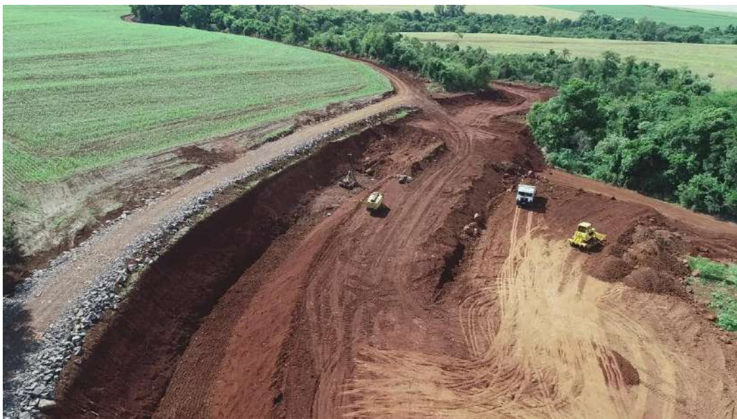
Figura 5.9: Abertura de estradas e Construção do canal adutor. Fonte: Construnível, 2020.
