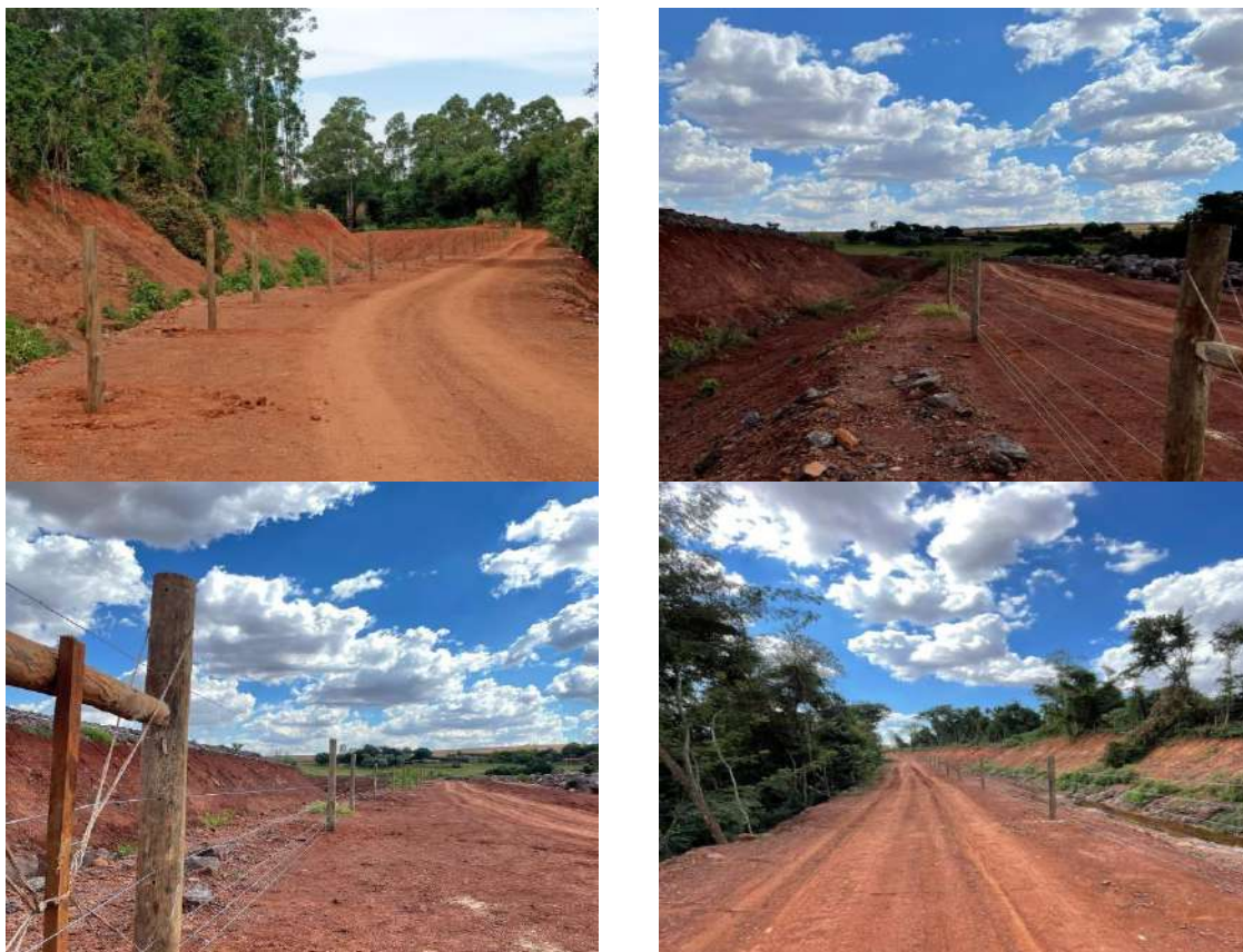
Figura 13.1: Instalação de Cerca. Fonte: Construnível, 2021.
