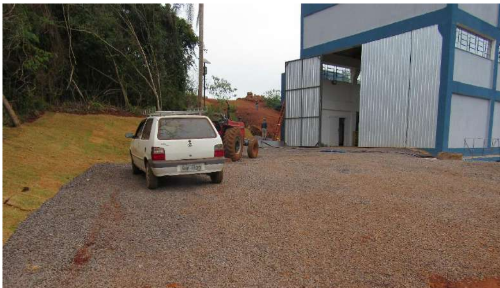
Figura 5.19: Casa de força finalizada e recuperado. Fonte: Construnível, 2021.
