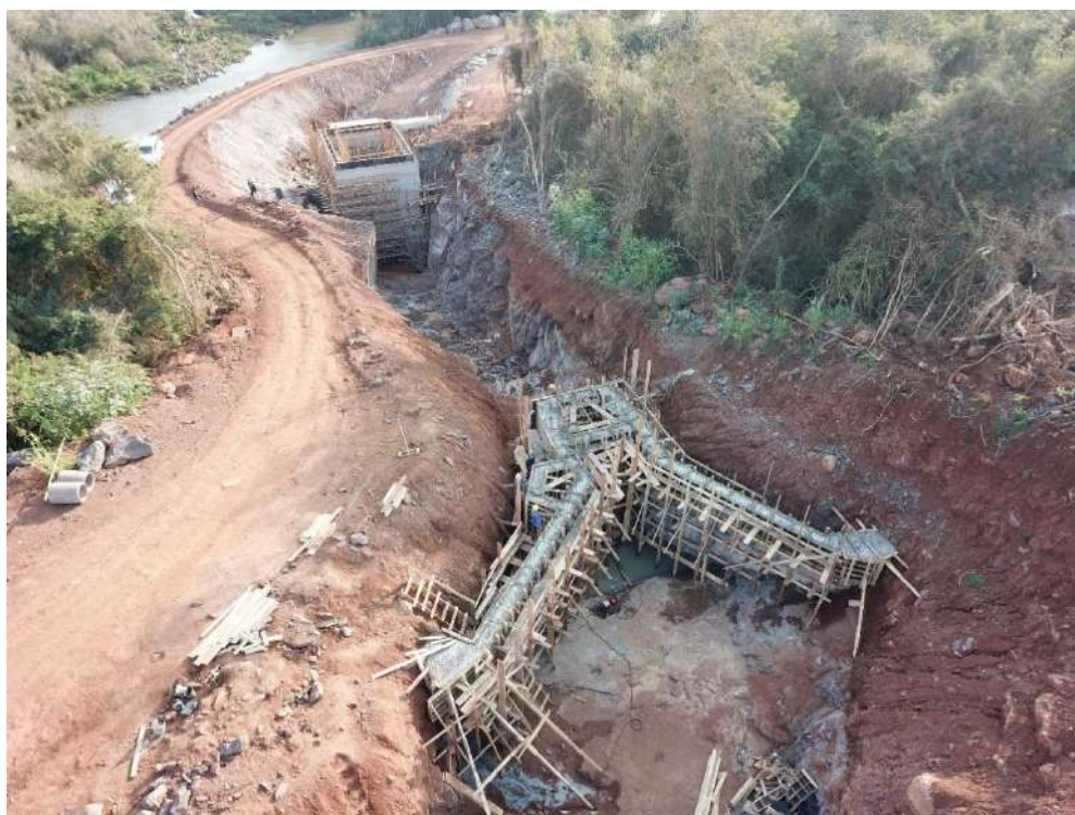
Figura 5.16: Andamento da construção da Casa de Força e Câmara de carga. Fonte: Construnível, 2020.
