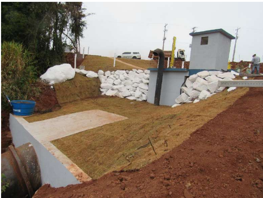
Figura 5.18: Câmara de carga finalizada e recuperado. Fonte: Construnível, 2021.
