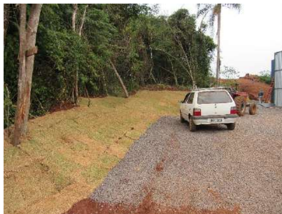
Figura 12.1: Recuperação de Taludes e plantio de gramíneas. Fonte: Construnível, 2021.
