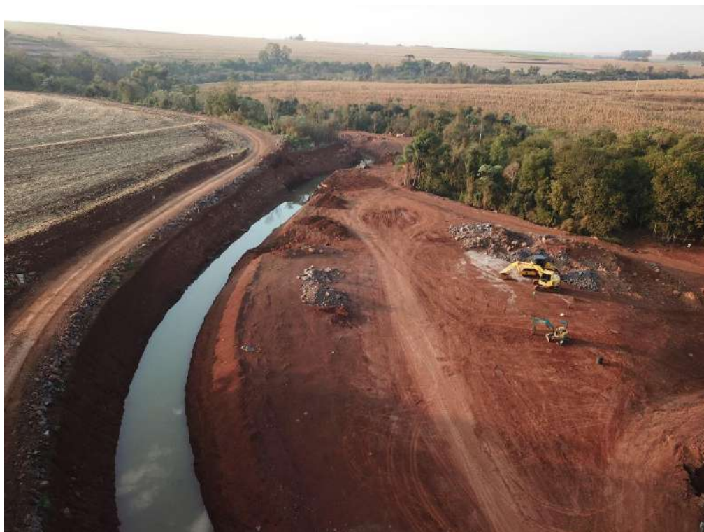
Figura 5.13: Canal adutor. Fonte: Construnível, 2020.
