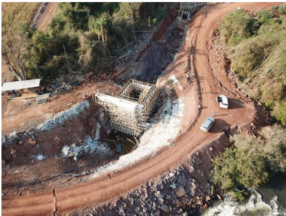
Figura 5.15: Andamento da construção da Casa de Força e Câmara de carga. Fonte: Construnível, 2020.
