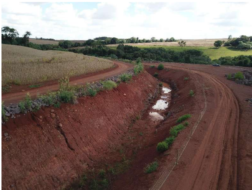
Figura 5.14: Canal adutor finalizado e parcialmente cercado. Fonte: Construnível, 2021.
