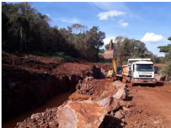
Figura 15.1: Construção da ensecadeira. Fonte: Construnível, 2020.
