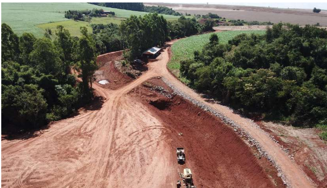
Figura 5.10: Abertura de estradas e Construção do canal adutor. Fonte: Construnível, 2020.
