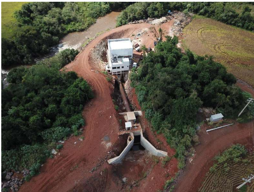
Figura 5.17: Andamento da construção da Casa de Força e Câmara de carga. Fonte: Construnível, 2021.
