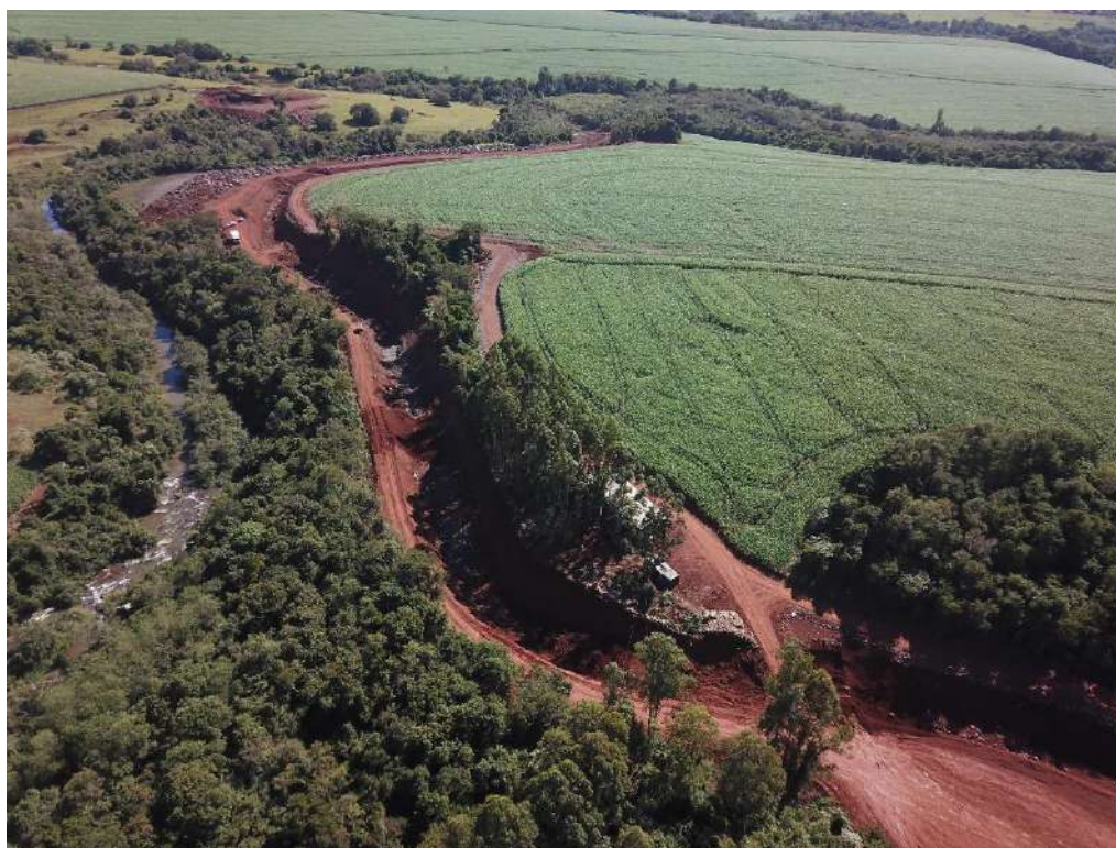
Figura 5.12: Construção do canal adutor. Fonte: Construnível, 2020.
