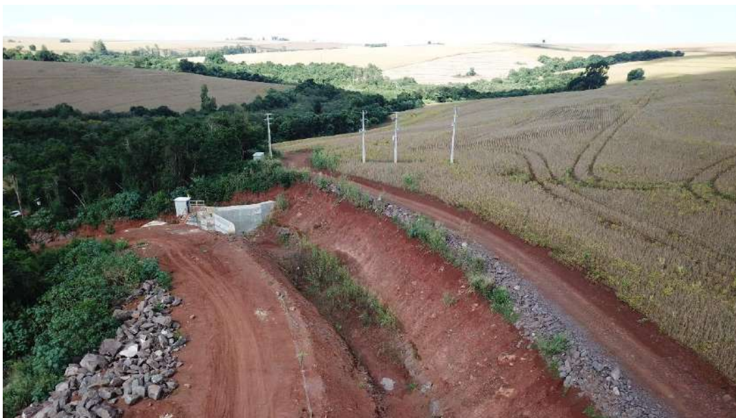
Figura 5.11: Abertura de estradas e Construção do canal adutor. Fonte: Construnível, 2021.
