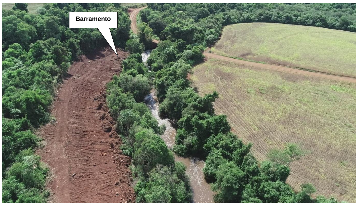
Figura 5: Imagem do local do barramento da CGH Germânia.
