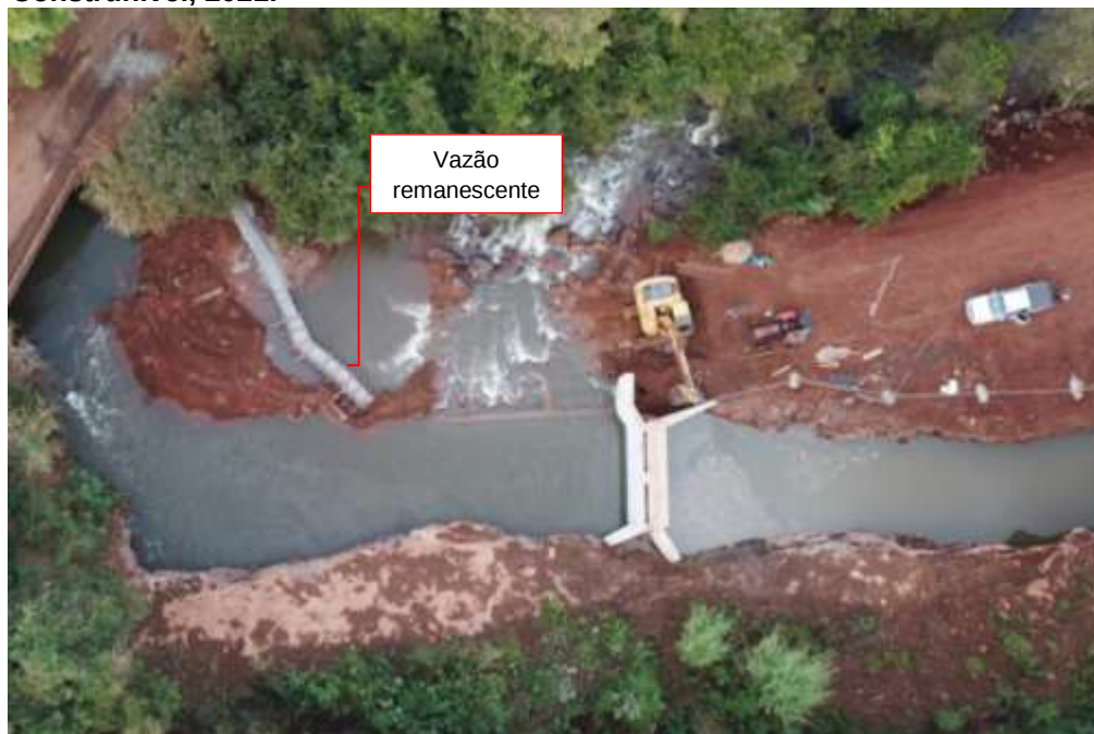
Figura 3.25: Imagem aérea do barramento executado.
