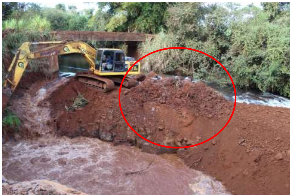
Figura 3.6: Material mole depositado em cima da ensecadeira. Fonte: Construnível, 2021.
