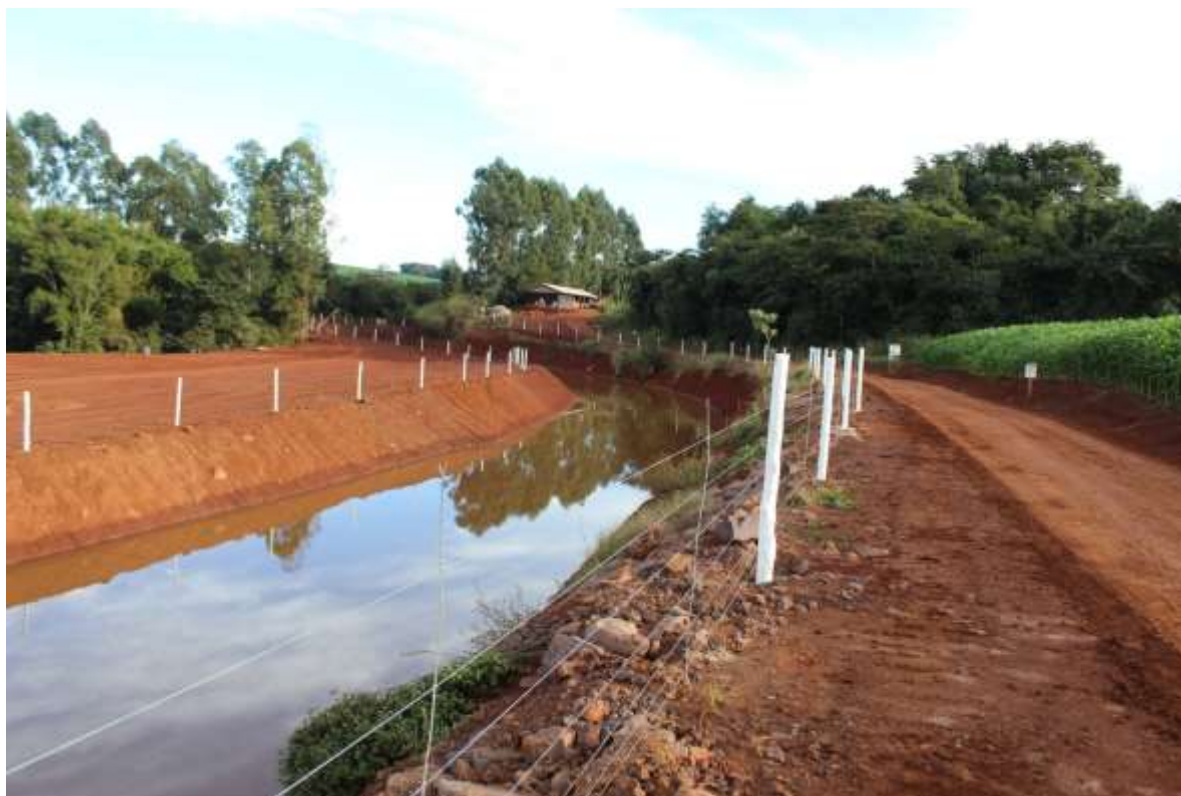
Figura 3.26: Situação do canal após o enchimento finalizado.
