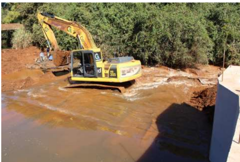
Figura 3.14: Local onde foi rebaixada a ensecadeira para extravasar o rio após enchimento total do canal. Fonte: Construnível, 2021.
