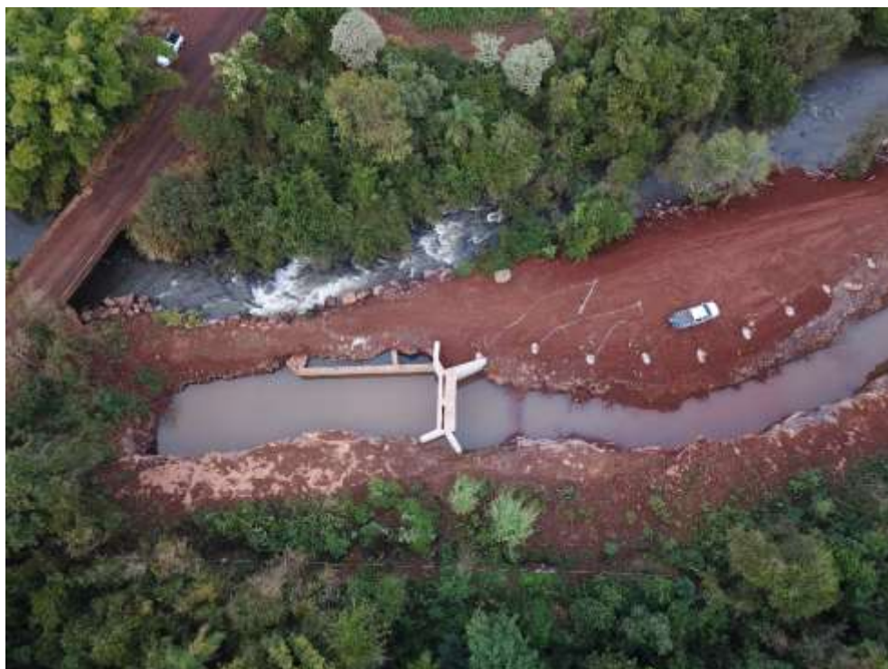
Figura 3.1: Foto de drone no barramento antes do início das atividades. Fonte: Construnível, 2021.
