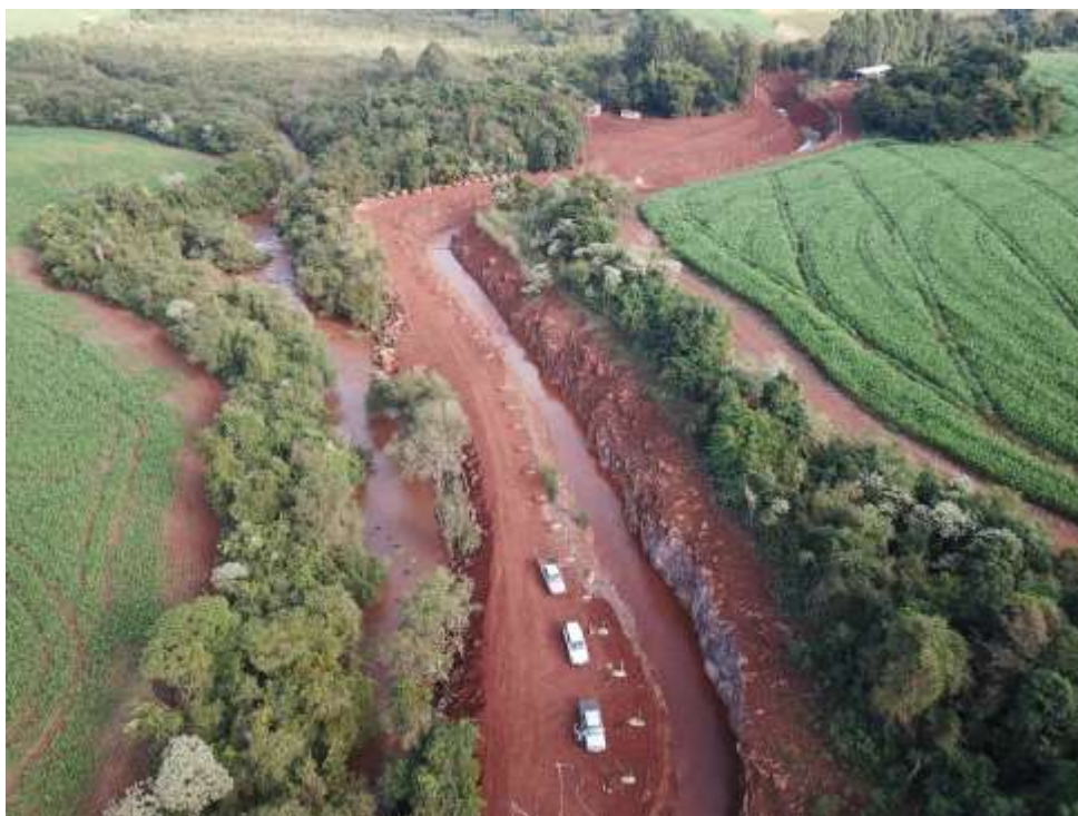
Figura 3.10: Foto aérea do canal após 1 hora da abertura da ensecadeira. Fonte: Construnível, 2021.
