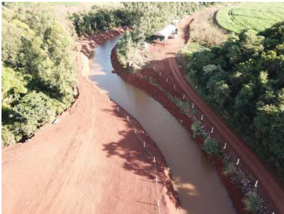
Figura 3.11: Foto aérea após 2h30 min da abertura da ensecadeira. Fonte: Construnível, 2021.
