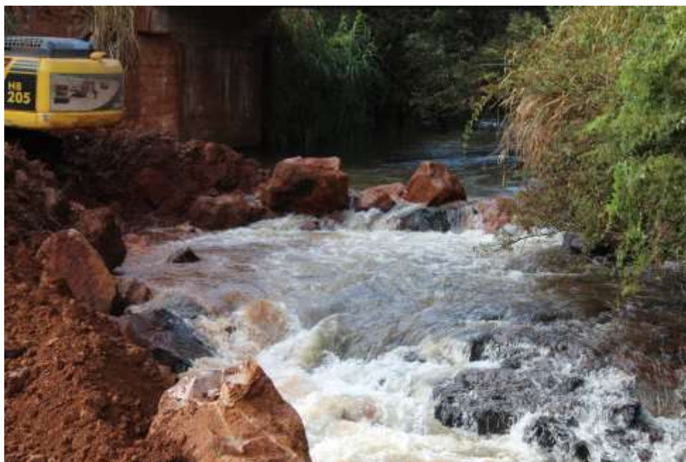
Figura 3.7: Matacos dispostos sobre o leito do Rio Verde. Fonte: Construnível, 2021.
