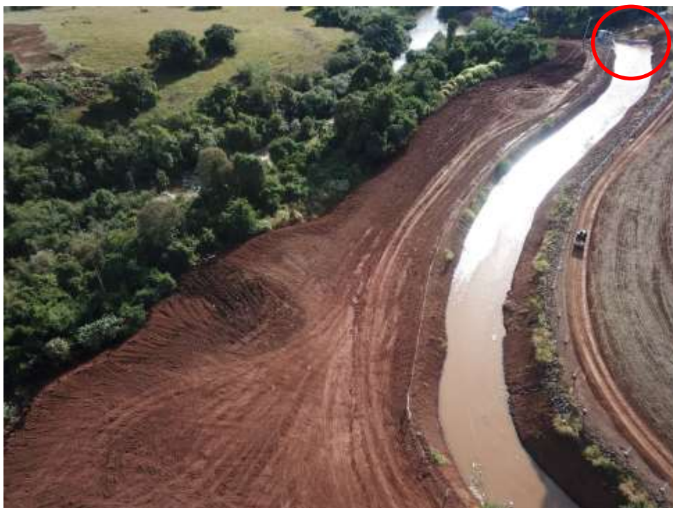
Figura 3.13: Foto aérea do canal após 4h30min da abertura da ensecadeira (Câmara de carga destaque em vermelho).
