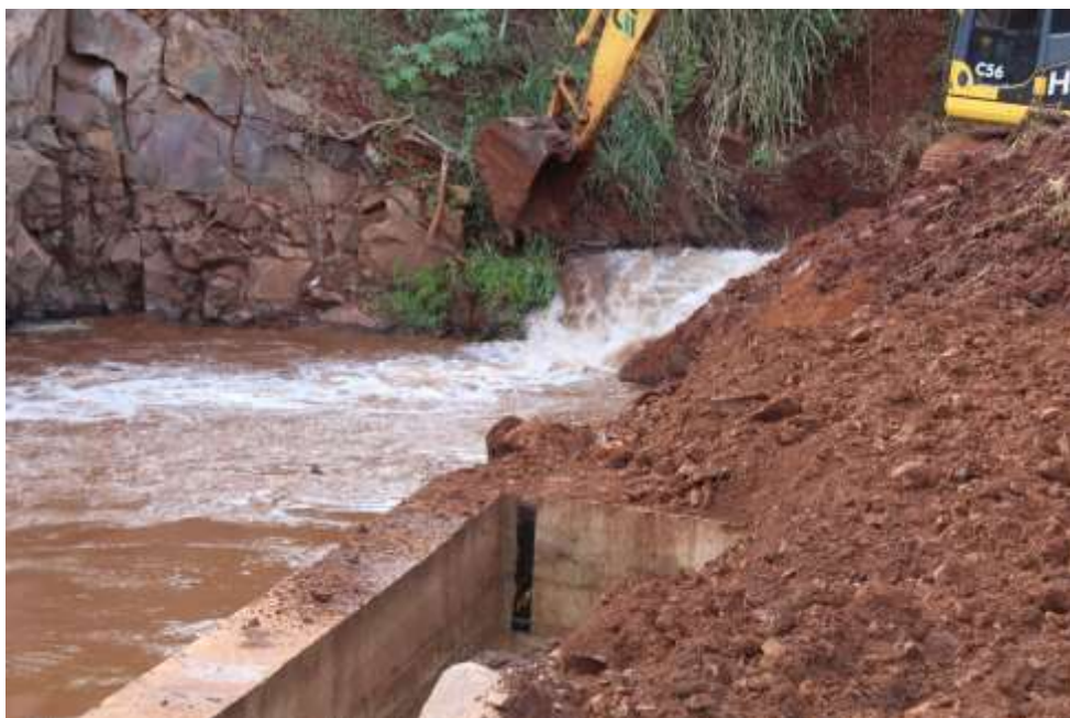
Figura 3.5: Alguns minutos após o início do enchimento do canal adutor. Fonte: Construnível, 2021.
