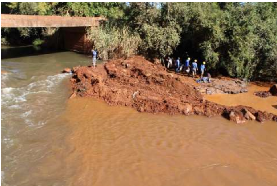
Figura 3.15: Ensecadeira finalizada e equipe realizando o resgate de fauna no trecho que ficou seco. Fonte: Construnível, 2021.
