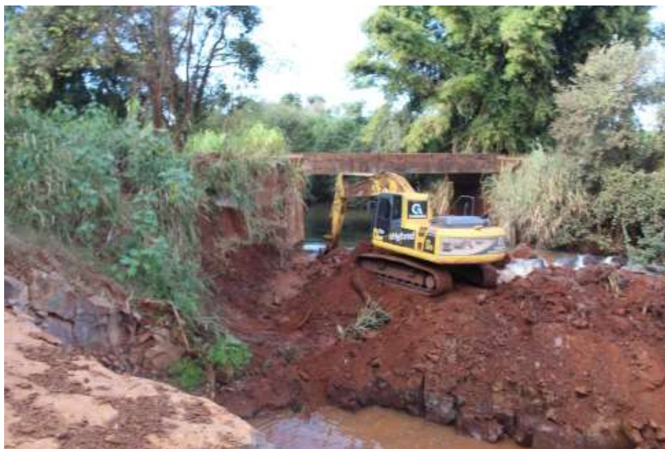
Figura 3.3: Início das atividades de desmonte da enseadeira. Fonte: Construnível, 2021.
