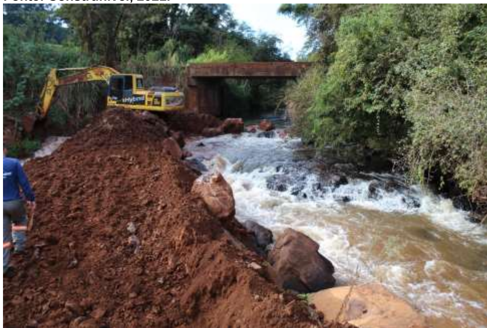
Figura 3.8: Técnico vistoriando o perímetro do canal e do rio (matacos postos sem impedimento no fluxo do rio). Fonte: Construnível, 2021.
