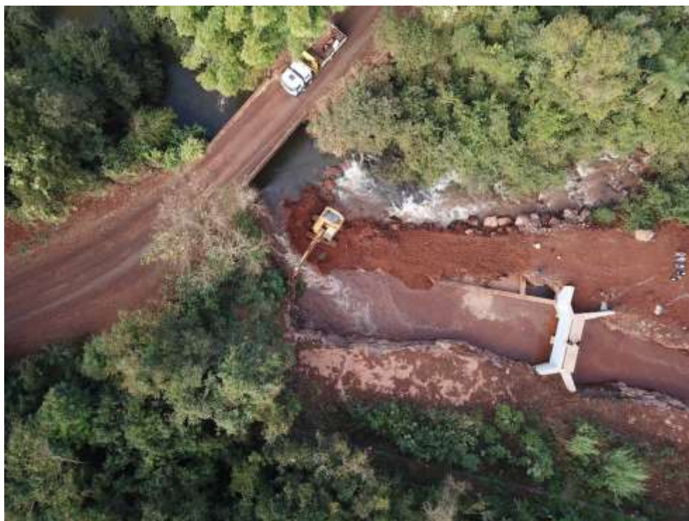
Figura 3.2: Foto com drone no barramento após o início das atividades de desmonte da ensecadeira no barramento. Fonte: Construnível, 2021.
