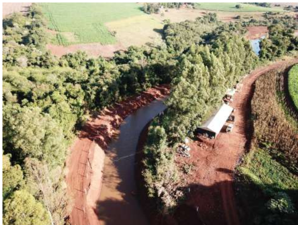
Figura 3.12: Foto aérea após 2h30 min da abertura da ensecadeira. Fonte: Construnível, 2021.
