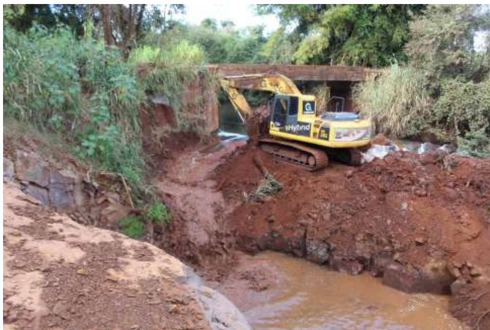
Figura 3.4: Momento em que a água do Rio Verde começa a adentrar no canal adutor. Fonte: Construnível, 2021.
