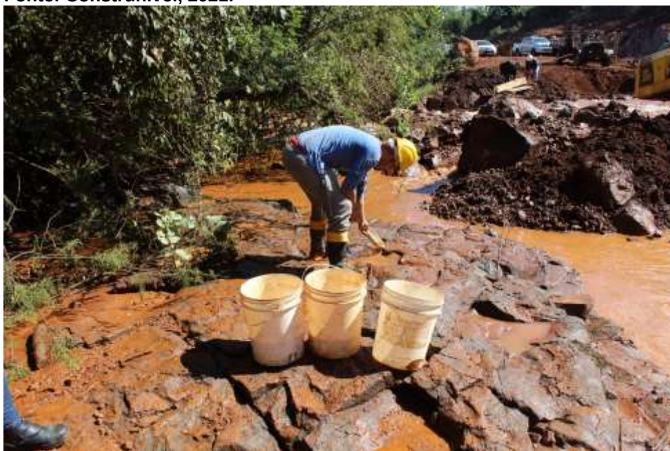
Figura 3.20: Trecho em que foi realizado o resgate de fauna. Fonte: Construnível, 2021.
